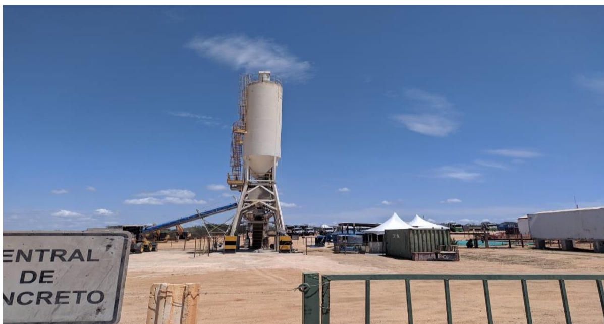
Figura 6 - Usina de concreto e container thermo king de armazenamento de gelo
