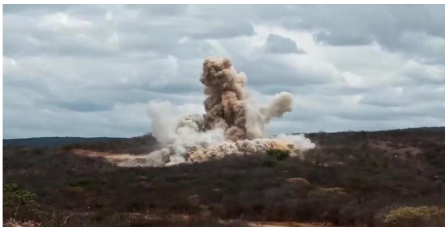
Figura 9 - Explosão com dinamites para fundação de aerogeradores do Complexo Eólico Chafariz Sul
