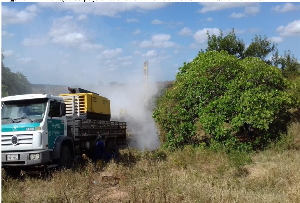
Figura 7 - Perfuração do poço artesiano na comunidade de Serra do Sítio Dona Inês PB.
