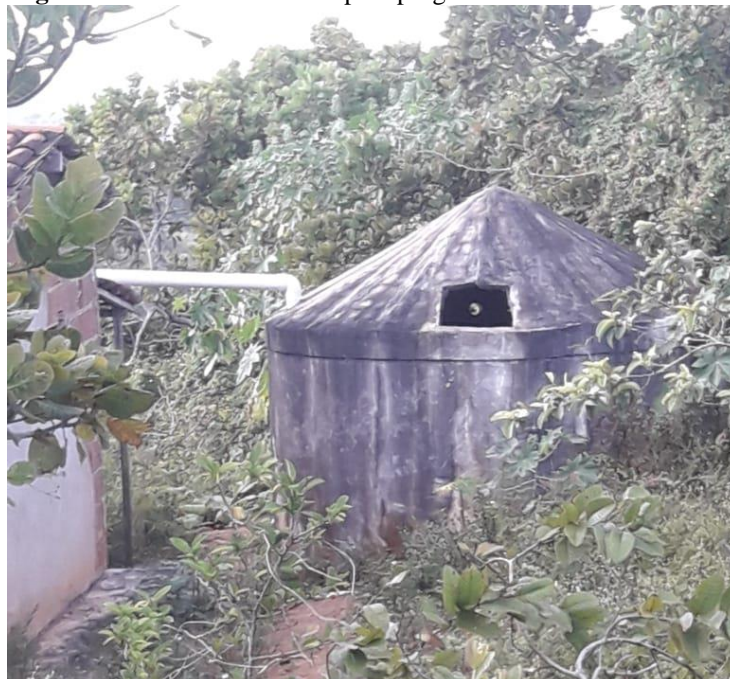
Figura 6 - Cisterna construída pelo programa Um Milhão de Cisternas.
