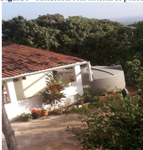
Figura 5 - Residência com cisterna de polietileno.
