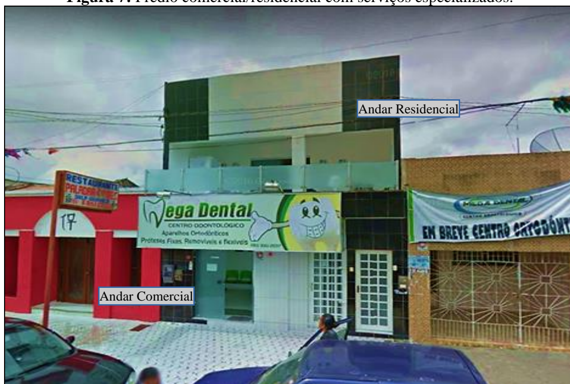
Figura 7: Prédio comercial/residencial com serviços especializados.
