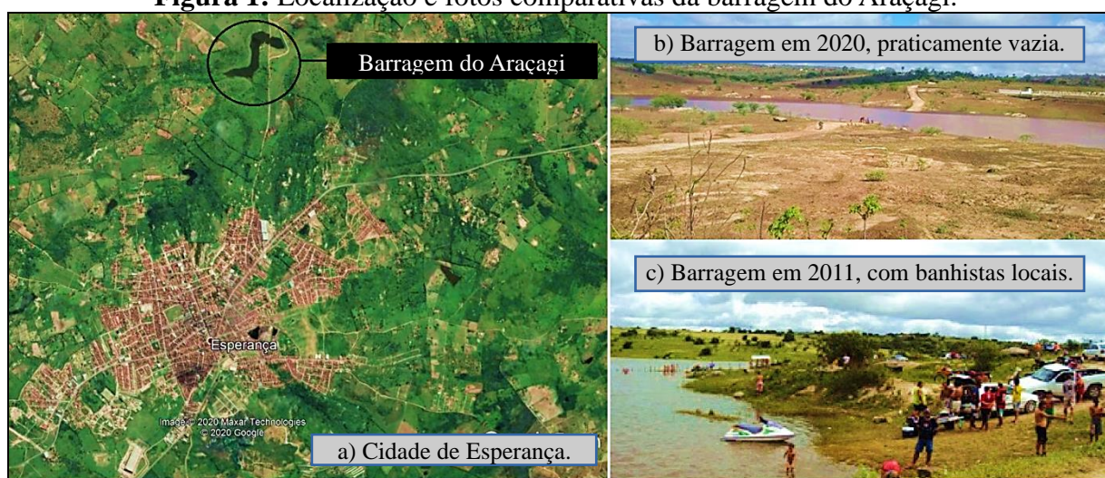
Figura 1: Localização e fotos comparativas da barragem do Araçagi.
