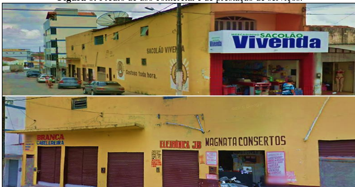
Figura 6: Prédio de uso comercial e de prestação de serviços.
