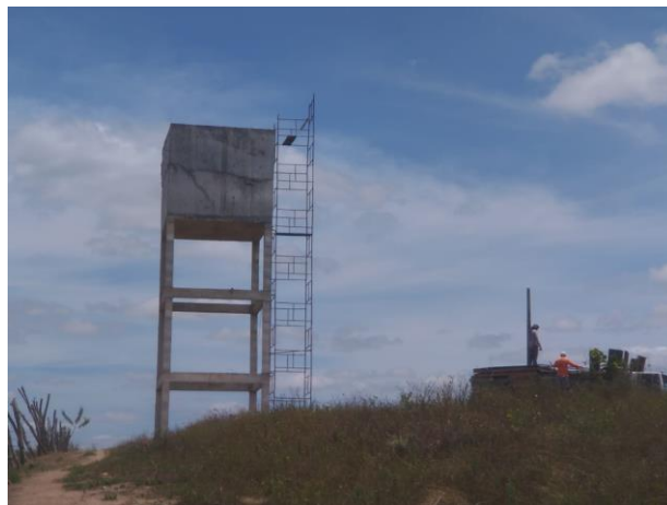
Figura 4 – Construção da Caixa d'água do Loteamento Monte das Oliveiras
