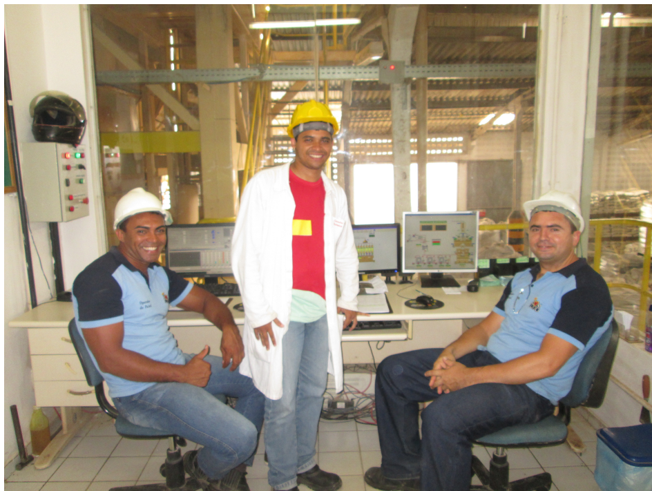
Figura 11. Sala de controle. Fonte: registro fotográfico do autor, 2019.
