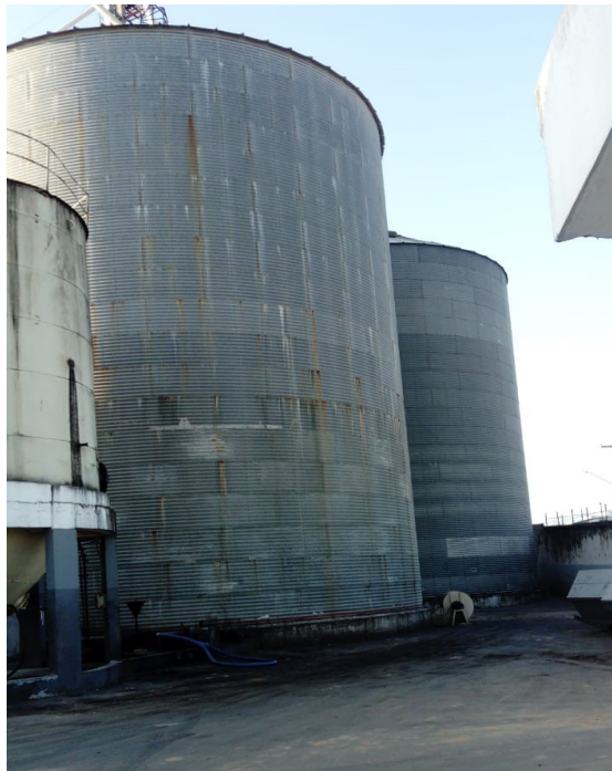
Figura 3. Silo externo de armazenagem de milho. Fonte: registro fotográfico do
