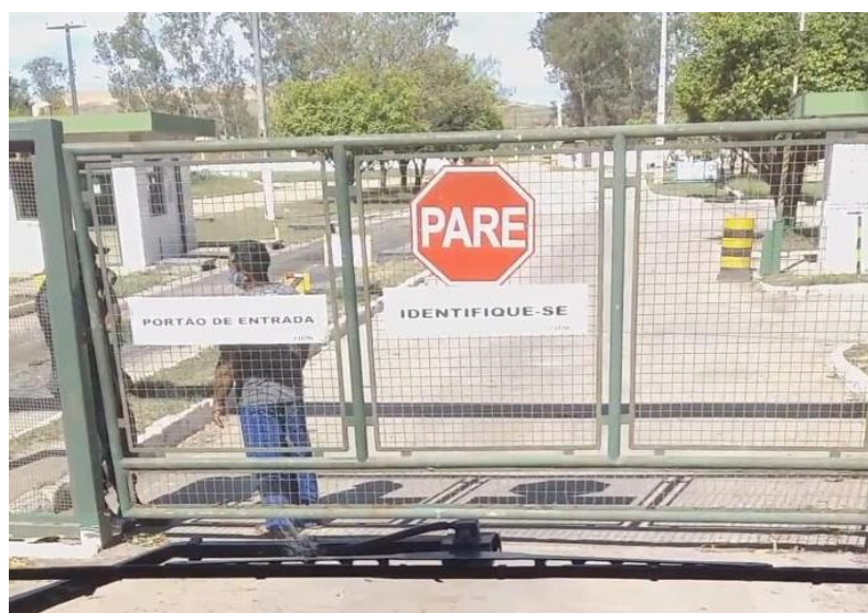
Figura 7 – Entrada do Aterro Sanitário Metropolitano de João Pessoa
