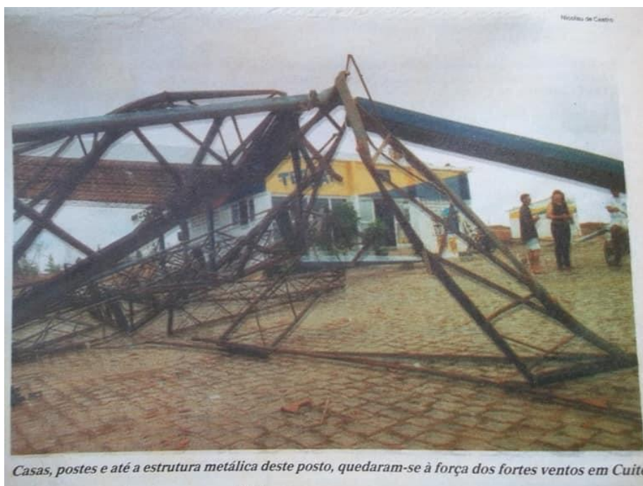
Figura 1 – Instalação metálica destruída pelo vendaval.
