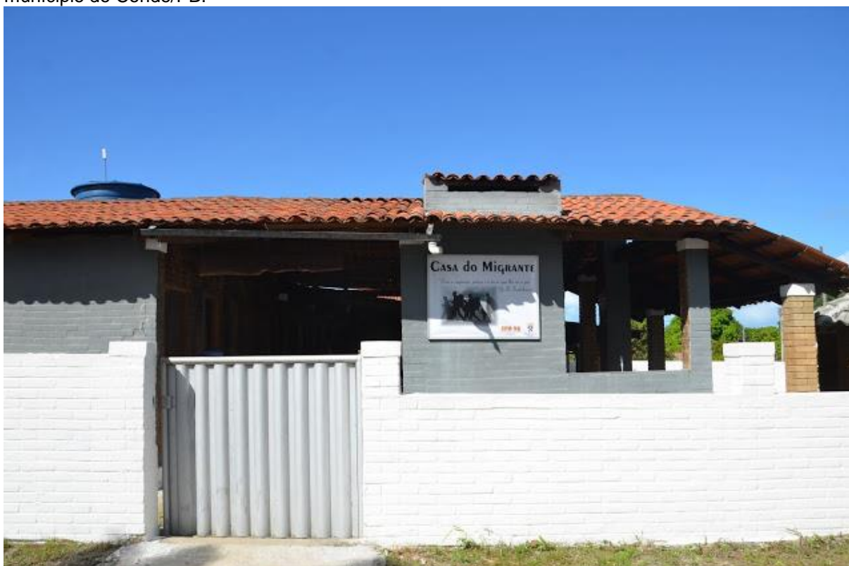
Figura 5 - Casa do Migrante, situada na Rua dos Tabajaras, S/N – Loteamento Village Jacumã, no município do Conde/PB.
