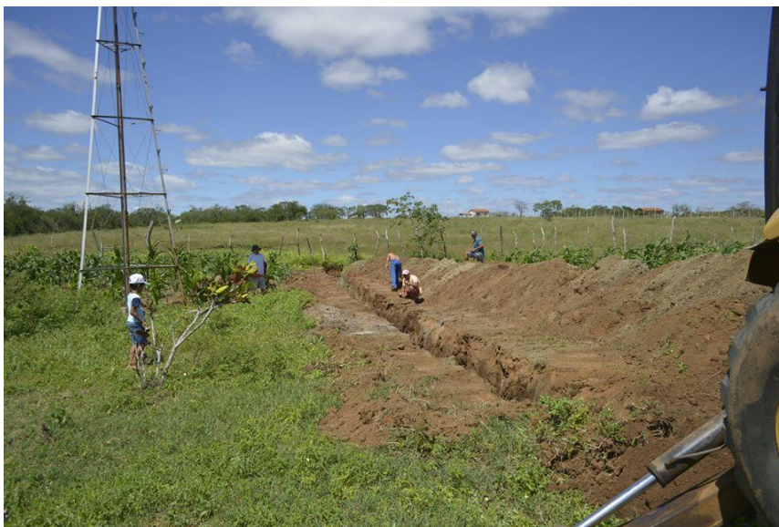
Figura 8: Construção da barragem
