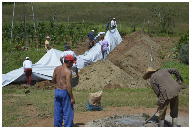
Figura 12: Impermeabilização da barragem
