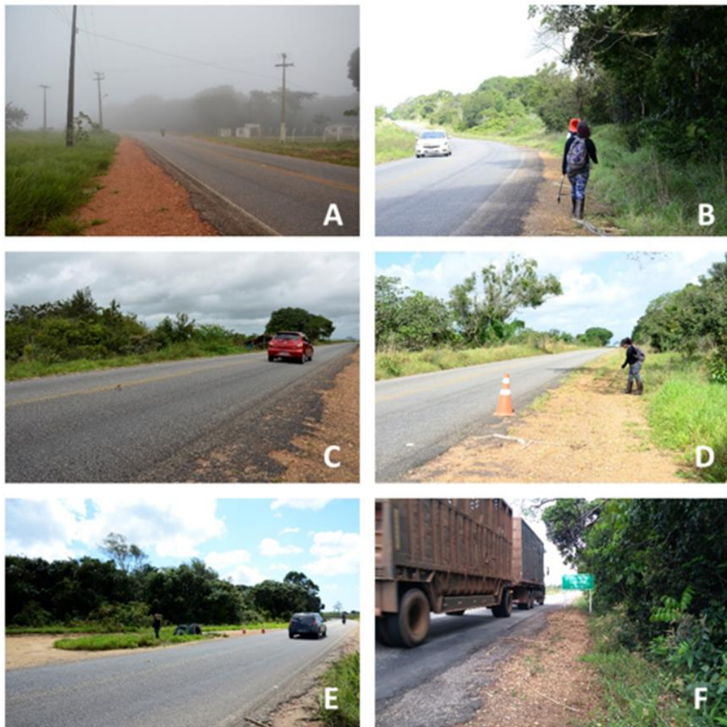
Figura 7. Vista do trecho monitorado da rodovia estadual PB 071 no entorno da SEMA II (Reserva Biológica Guaribas, município de Mamanguape, estado da Paraíba, Nordeste do Brasil) para registro de répteis atropelados. Abreviaturas: A (Frente da sede da SEMA II no início da manhã. Neblina ao amanhecer eram recorrentes nos períodos mais chuvosos), B (Monitoramento na faixa de acostamento contígua com a borda da mata), C (Vista da faixa da rodovia oposta àquela indicada em B), D (Registro de um espécime atropelado no acostamento. Cones de sinalização eram postos para alertar os motoristas sobre a presença de pesquisadores no acostamento), E (Rotatória improvisada ligando a PB-071 a outra estrada de terra que corta a SEMA II (sentido do município de Jacaraú) e F (Treminhões vistos com frequência trafegando na PB-071 nas épocas de corte e colheita das plantações de cana-de-açúcar). Fotos: Mayanne Albuquerque Carvalho (2019).
