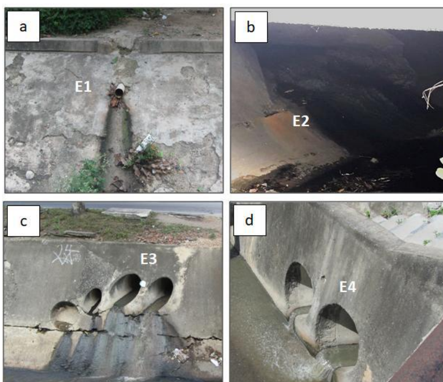
Figura 8 – Pontos de contribuição de esgoto.
