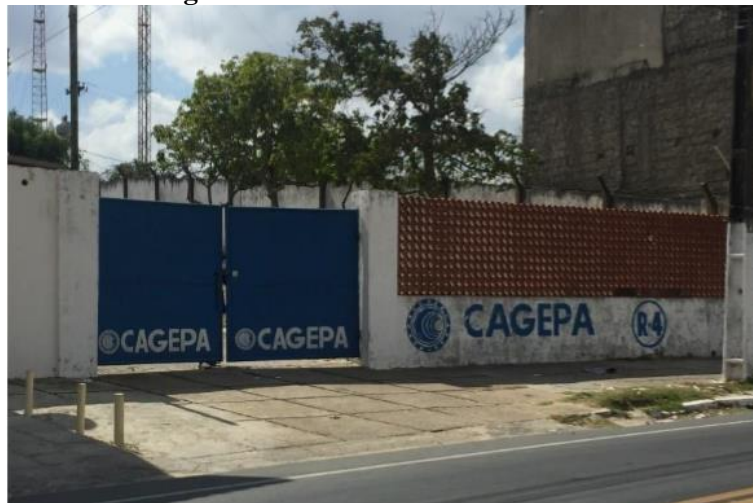
Figura 6 - Fachada do reservatório R4
