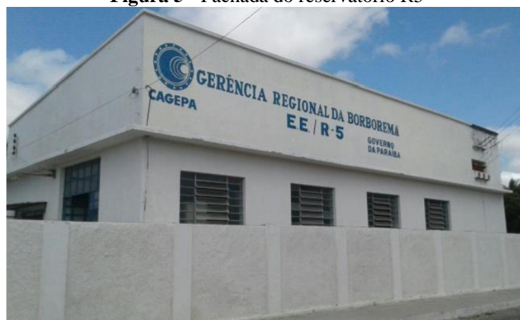
Figura 5 - Fachada do reservatório R5
