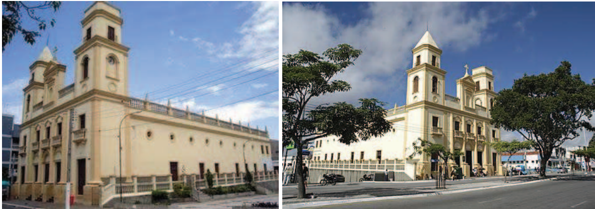
Figura 08. Vista externa da Catedral de Campina Grande.
