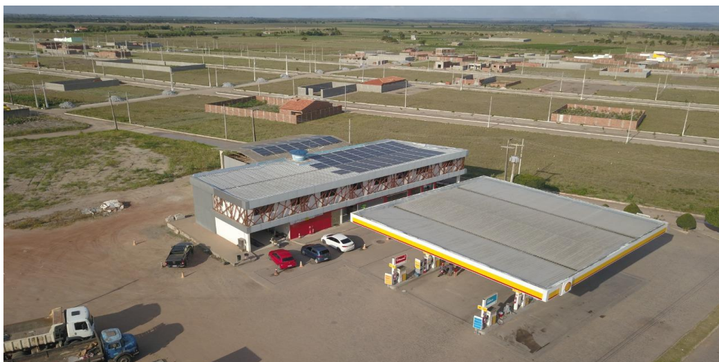
Figura 5 – Painéis solares dispostos sobre telhados de UC comercial.
