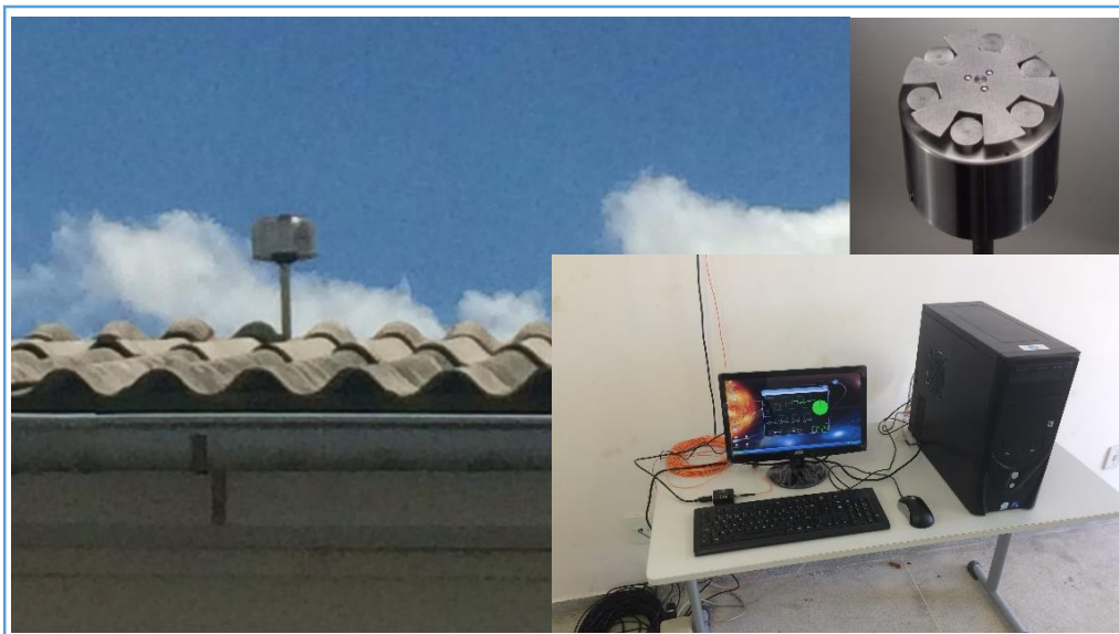
Figura 4 – Imagens do sensor de campo elétrico EFM-100 (canto superior direito), instalado sobre um prédio localizado no Campus de Lagoa Seca; sistema de gerenciamento de dados (canto inferior direito).
