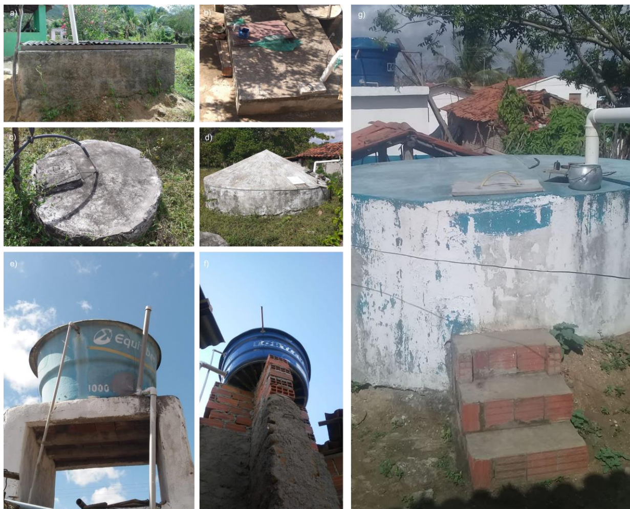
Figura 11: Formas de armazenamento de água registrada pelos alunos. (a) (b) (c) (d) e (g) , cisternas construídas em moradias da zona rural da cidade. (e) e (f) caixas d'água de residências da zona urbana de Mogeiro.
