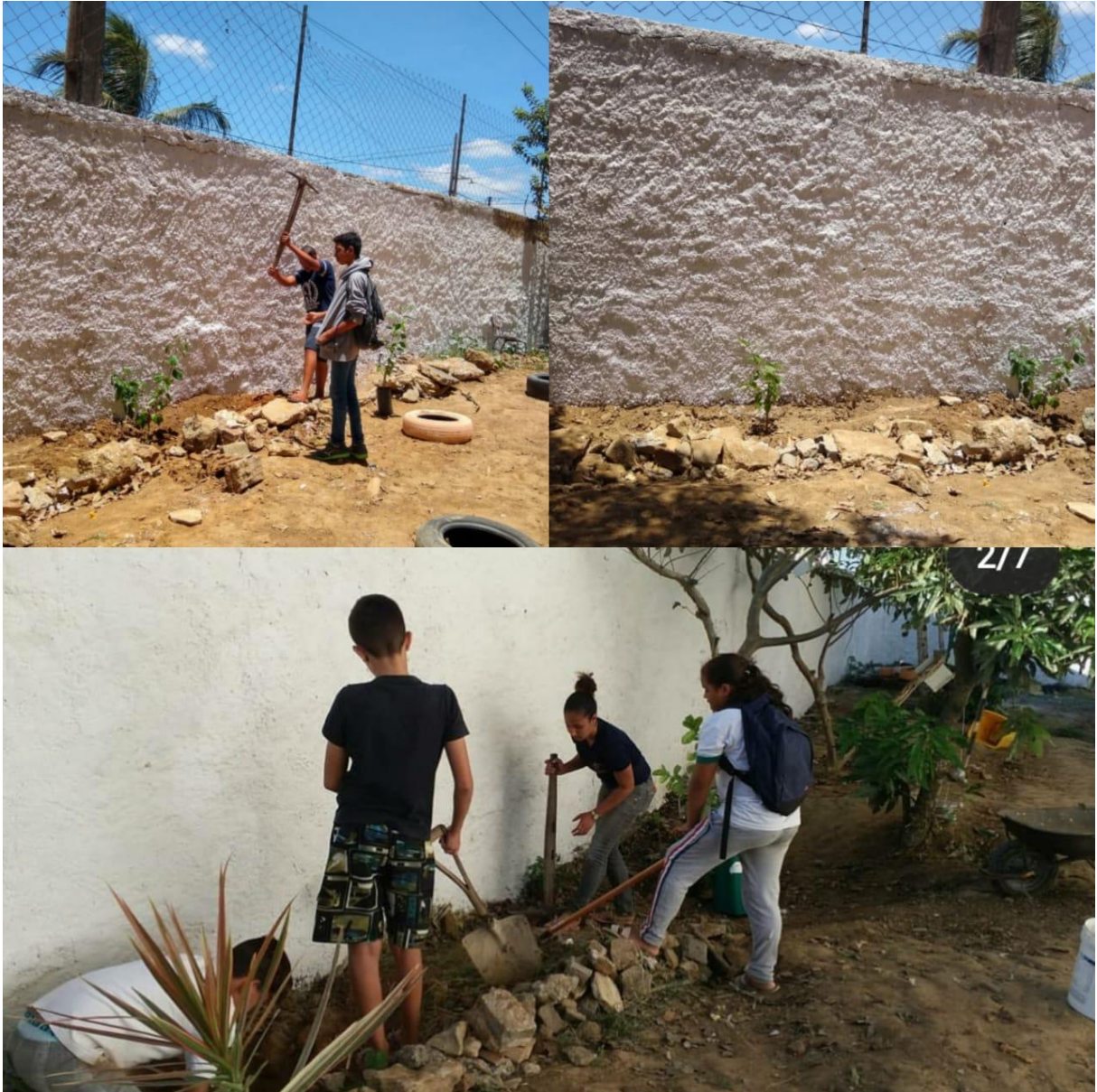
Fig. 29. Construção do canteiro.
