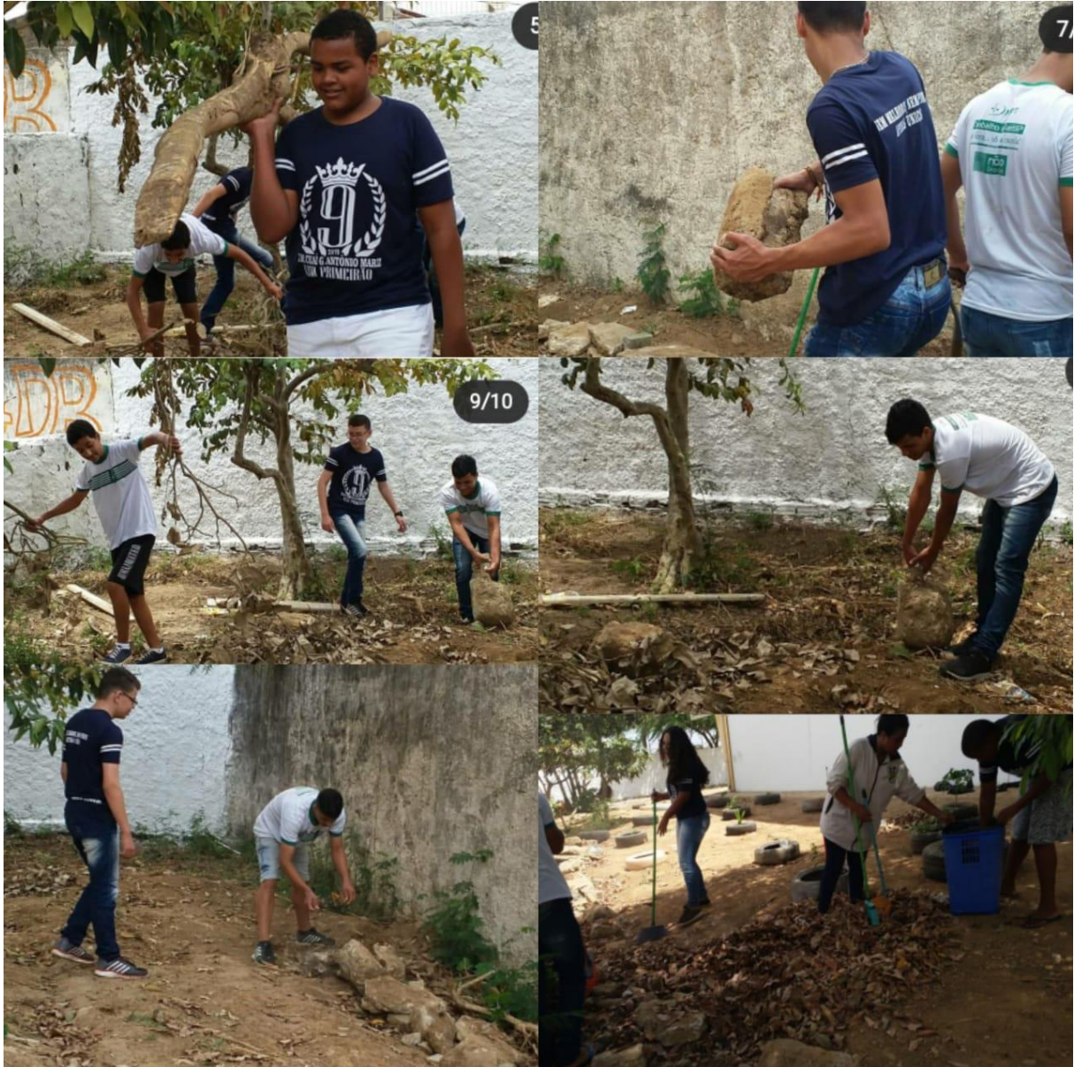
Fig. 26. Dia de limpeza e remoção de entulho.
