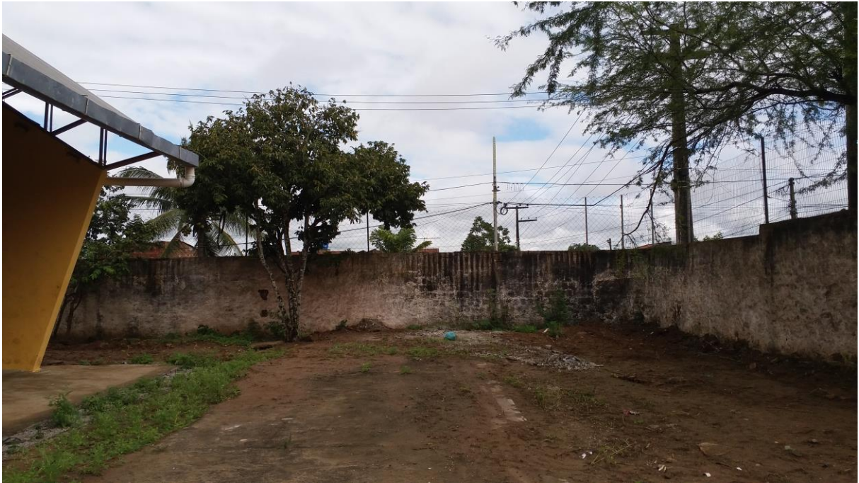
Fig. 31. Local que foi plantada as mudas para formar o corredor de árvores.
