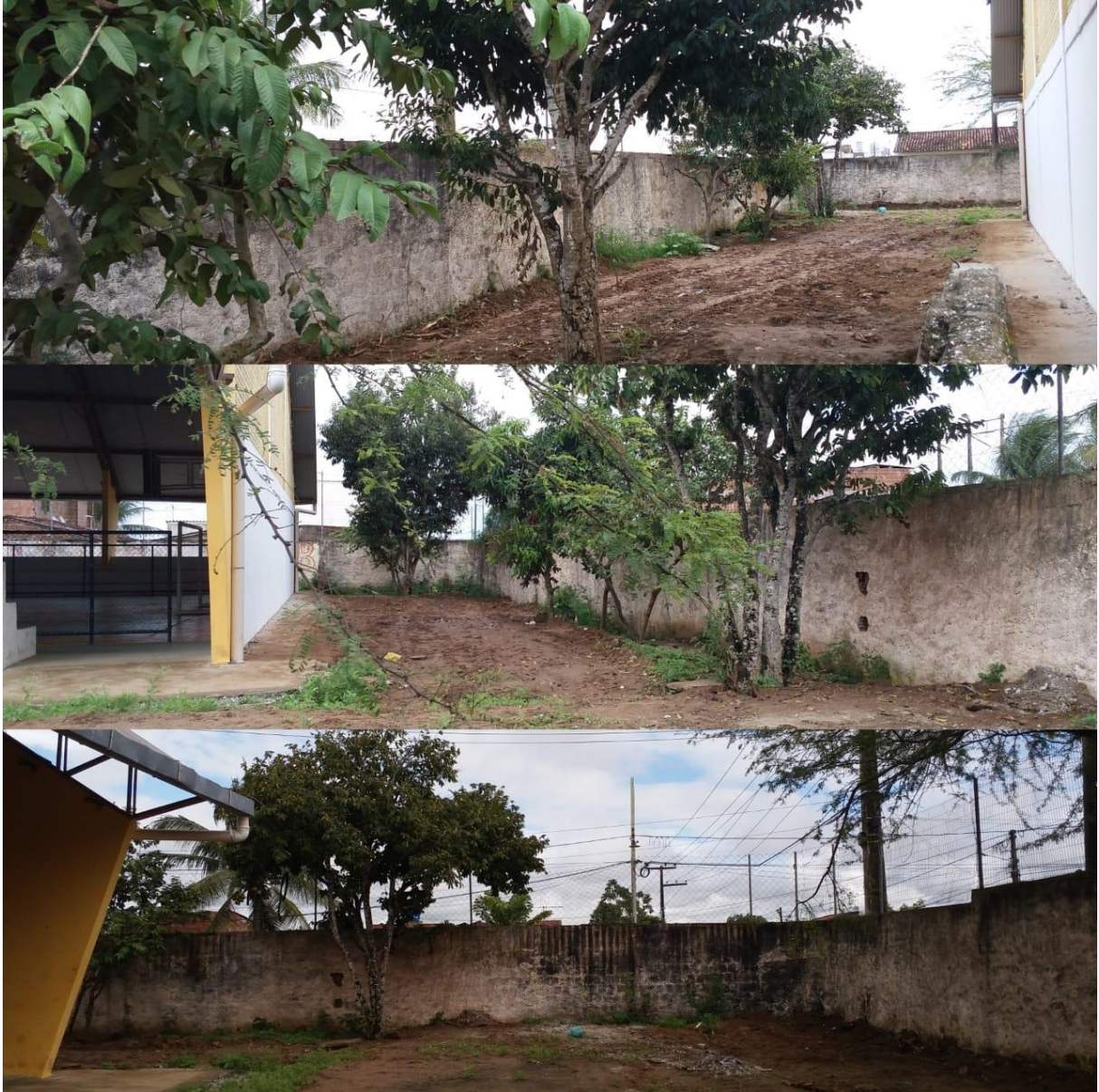
Fig. 04. Local da terraplenagem para iniciar as atividades do projeto.
