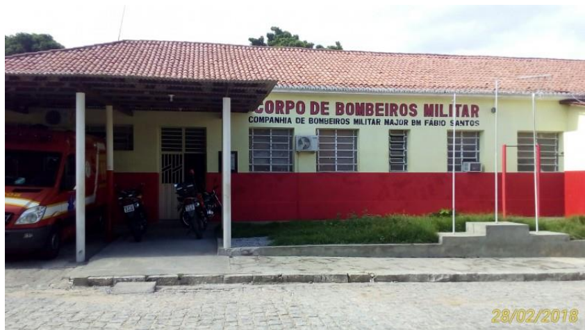
Figura 1: Fotografia da sede da 2ªCBM/6ºBBM.
