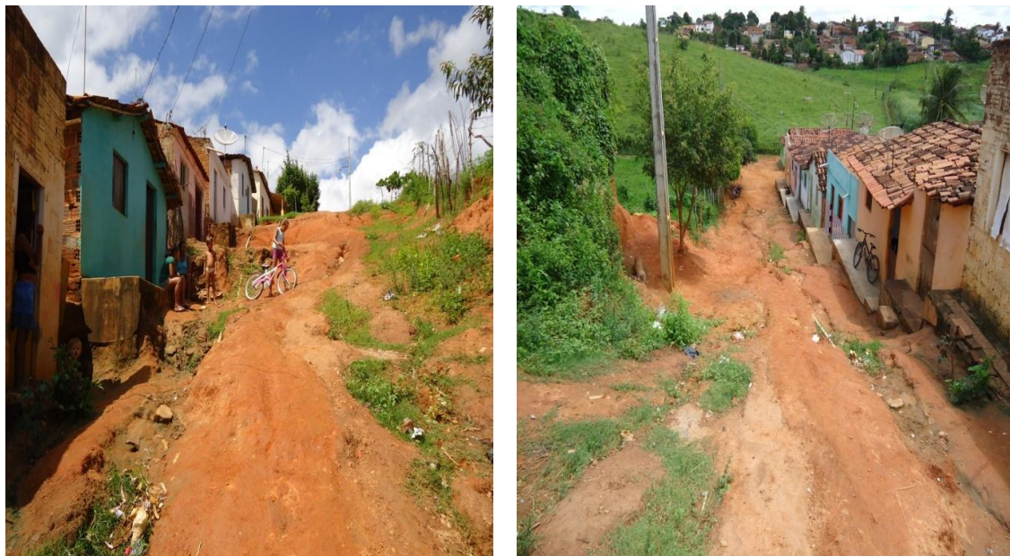
Figuras 14 e 15: Ausência de Pavimentação. Rua Manoel A. Ferreira, Bairro alto do Damião. Fonte: Arquivo do autor, Julho 2012.
