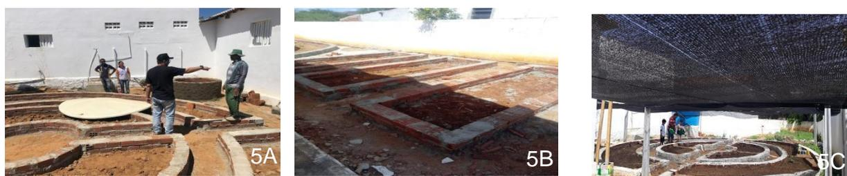
**Figura 10.** Horta na Escola Municipal de Ensino Fundamental José Mariano, Junco do Seridó-PB. A. Construção dos canteiros da horta mandala com alvenaria. B. Construção dos canteiros laterais. C. Sombrite instalado na horta. Fonte: Acervo Zika UEPB.
