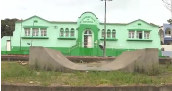
Figura 4 – Abandono quando da reforma da Praça (2018)
