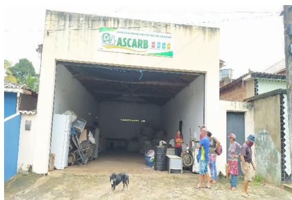
Figura 13: fachada do galpão da associação.
