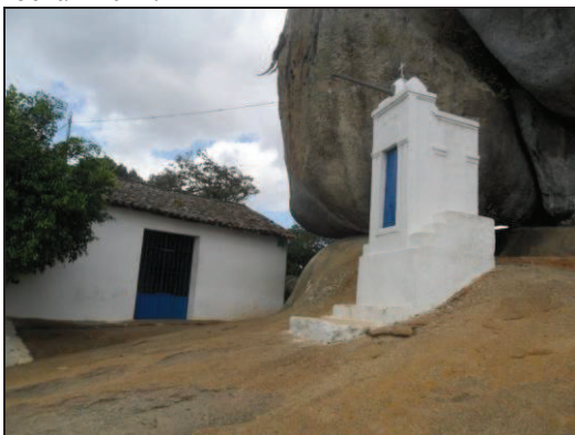
Foto 07: Edificações religiosas próximas à rocha - 2012.
