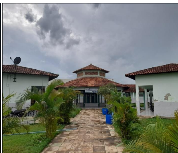
Figura 7: Parte interna da Escola Tiradentes
