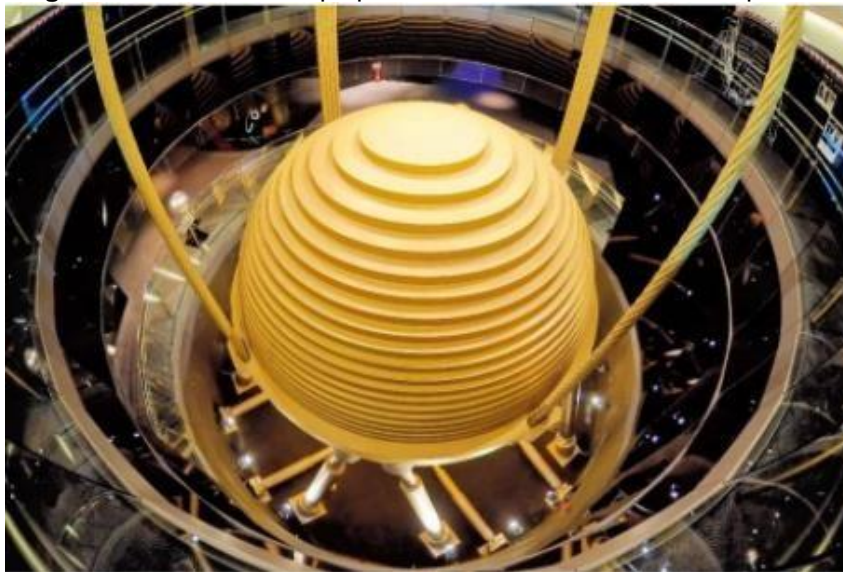
Figura 5: Atenuador do tipo pendular instalado do edifício Taipei 101.
