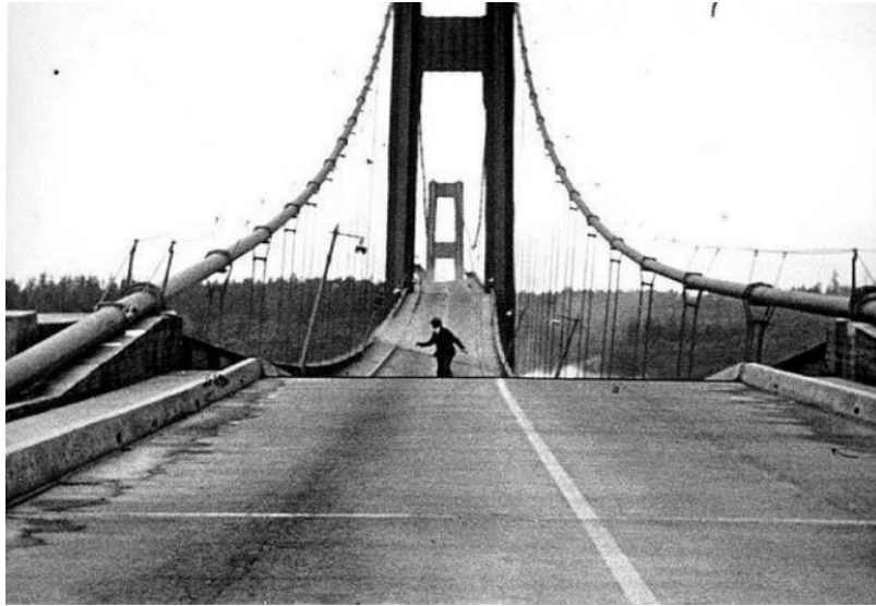
Figura 1: Homem correndo na ponte Tacoma Narrows durante a oscilação.
