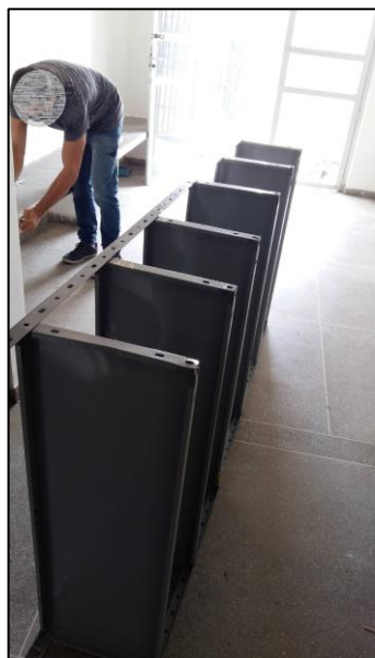
Figura 7 – Montagem das estantes
