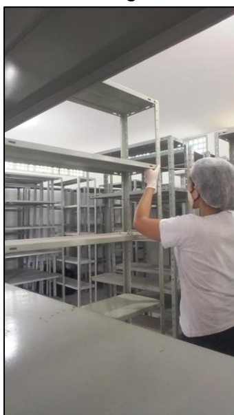
Figura 27 – Montagem das estantes
