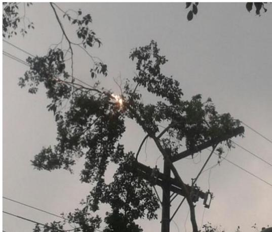
Figura 17. Árvore se chocando com rede elétrica de distribuição.
