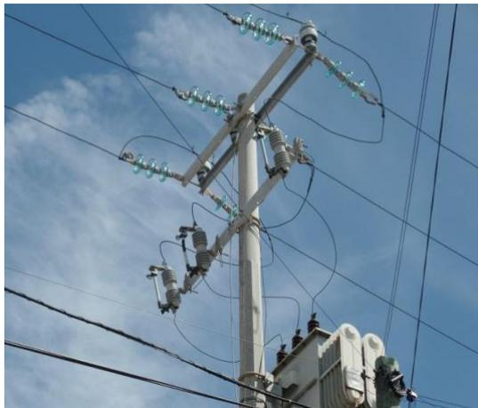
Figura 16. Circuito elétrico com Chave Fusível e Transformador de Distribuição.
