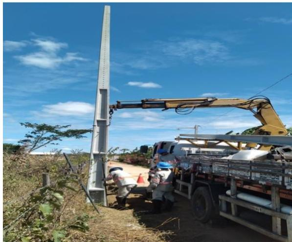
Figura 8. Equipe de Linha Morta realizando a manutenção de redes em ação.
