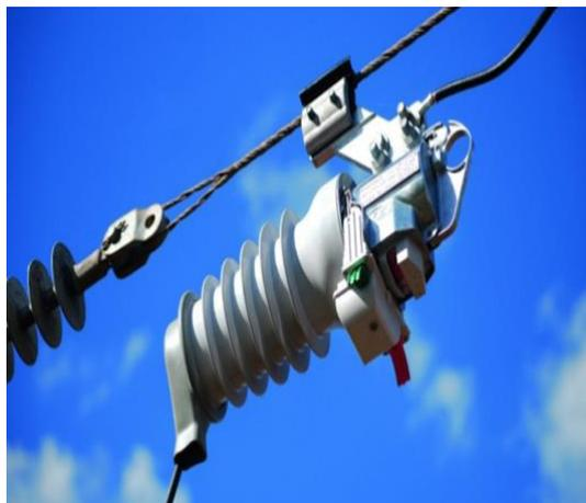
Figura 21. Fusesaver Siemens. Fonte: [www.siemens.com/Fusesaver](http://www.siemens.com/Fusesaver). Acesso em 01 de maio de 2022.
