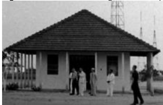
Figura 13: Pavilhão de Passageiros da Aéropostale .
