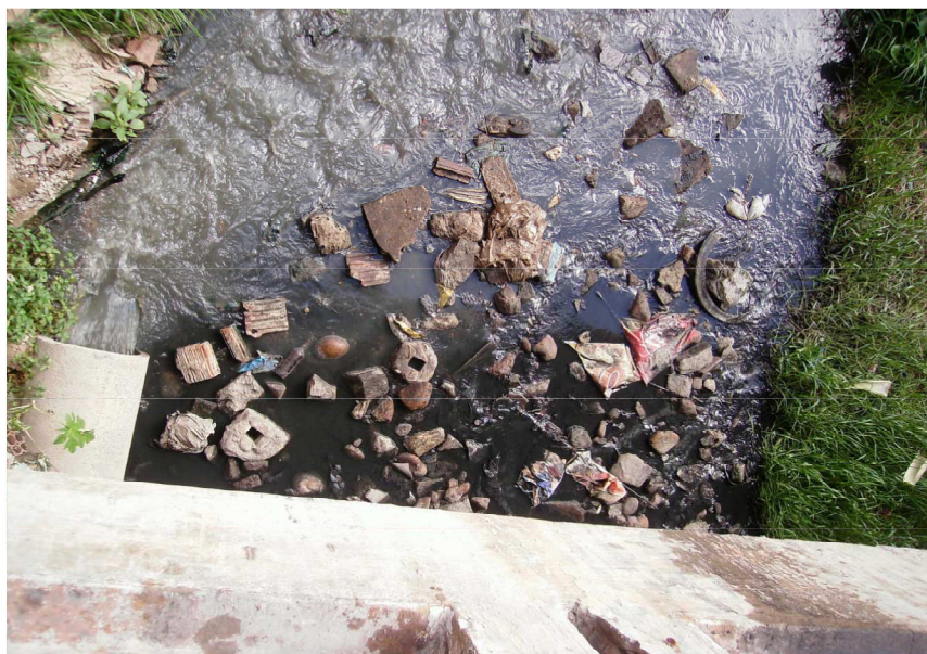
Figura 10: Rede de esgoto lançada no rio Espinharas na cidade de Patos-PB Fonte: Campo de pesquisa
