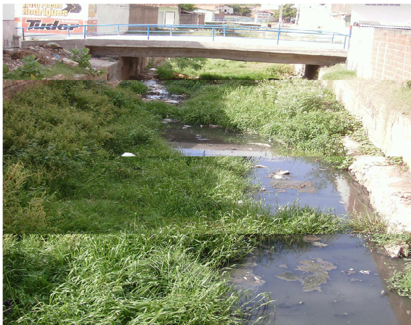
Figura 9: Esgoto a céu aberto na cidade de Patos-PB Fonte: Campo de pesquisa
