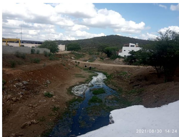
Figura 16: Vista do riacho Tapera sobre a “ponte velha” em 2021. Fonte: acervo pessoal do autor.
