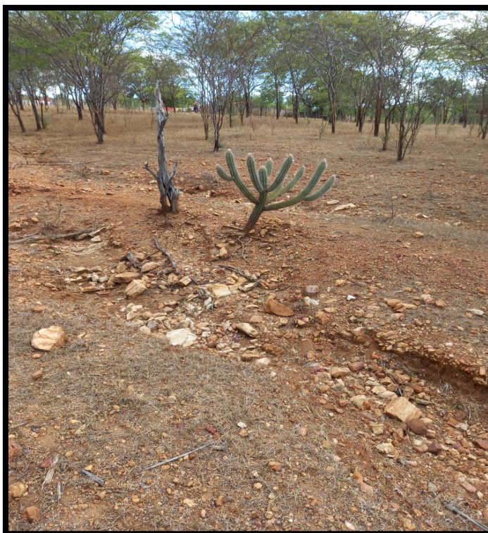
Figura 5: Processo de erosão pluvial.
