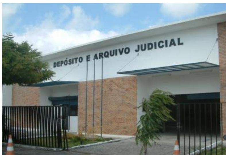
FIGURA 4: Fachada do depósito e arquivo judicial
