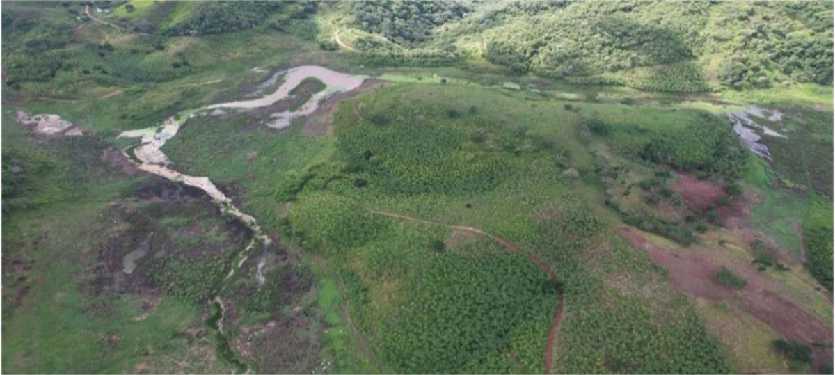
Figura 3 - Barragem de Canafístula I em seu volume de água colapsado registrada em 03/02/2022.
