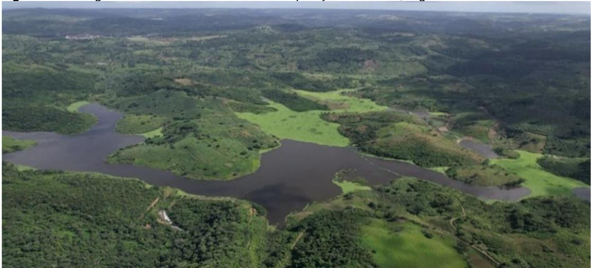
Figura 2 - Barragem de Canafístula I com sua composição em 100%, registrada em 07/07/2022.
