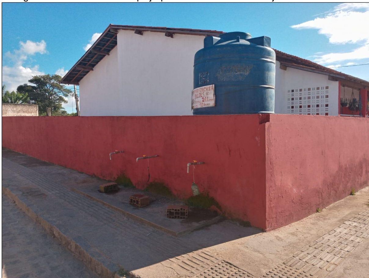
Figura 13: Parte externa do poço público localizado no Conjunto Padre Leonardo.
