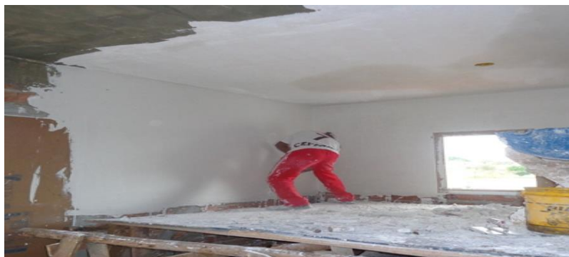
Figura 4 Aplicação de gesso em teto
