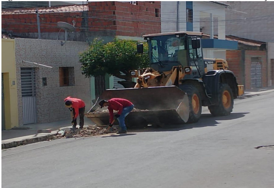
Figura 10- Funcionários públicos realizando a coleta dos Resíduos de construção.
