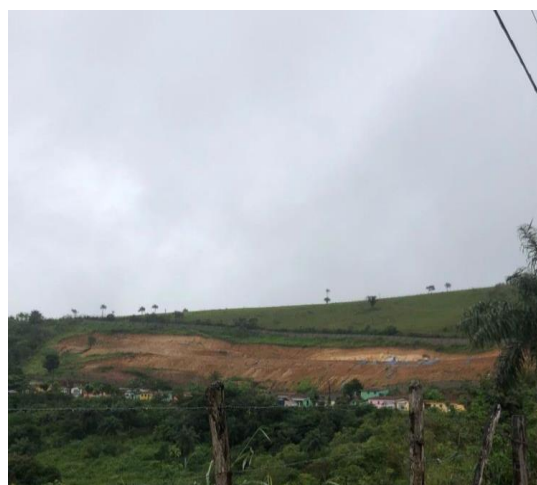
Figura 12: Imagens da construção do Condomínio Gran Ville no terreno por cima do túnel 2022
