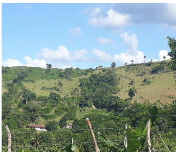
Figura 11: Imagens da vegetação do terreno por cima do túnel em 2017
