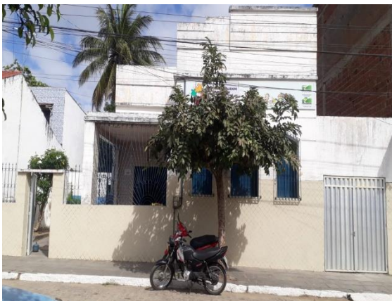
IMAGEM DA FRENTE DO PRÉDIO
