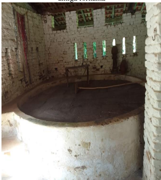
Figura 17: Palco para eventos em formato de antiga fornalha
