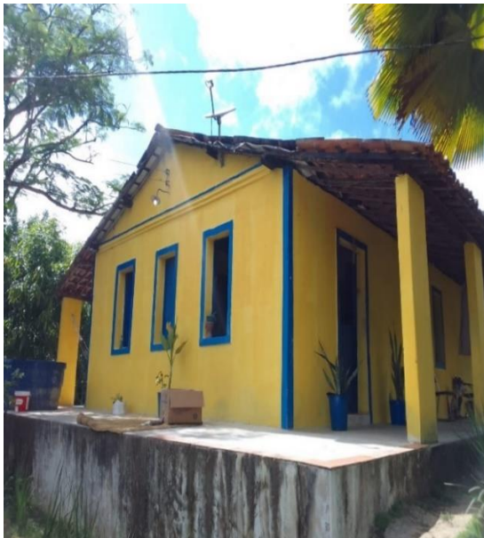
Figura 06: Antiga casa do senhor de Engenho no Pacas
