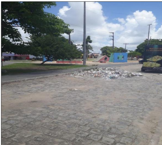
Figura 20 – Resíduos sólidos de obra lançado em plena praça pública
