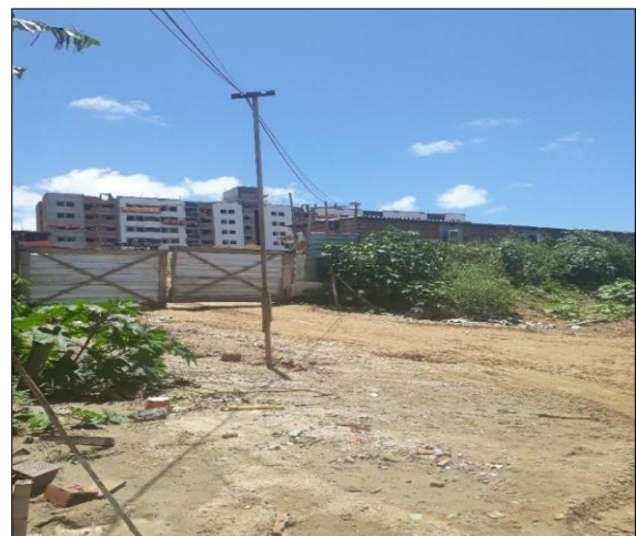
Figura 16 – Construção de um condomínio residencial
