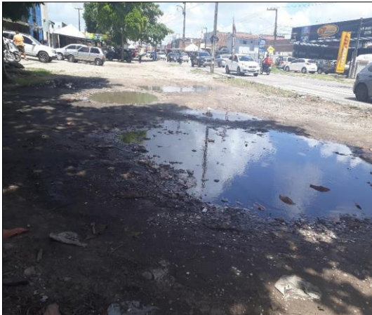
Figura 22 – Compactação do solo
