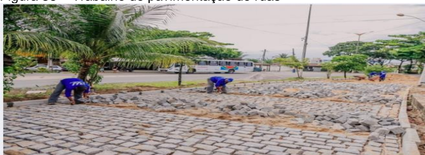
Figura 35 – Trabalho de pavimentação de ruas
