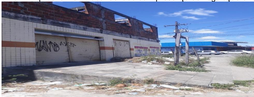
Figura 13 – Empreendimento abandonado com presença de vegetação e resíduos
