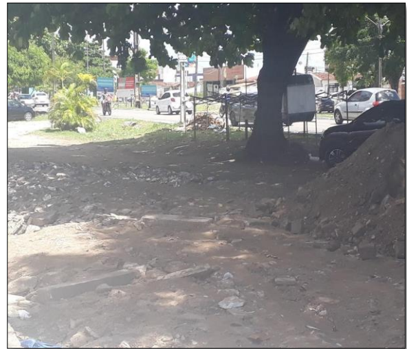
Figura 21 – Acúmulo de sedimentos de obras
