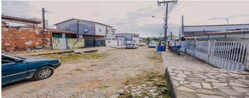
Figura 17 – Rua do bairro Cuiá sem calçamento
