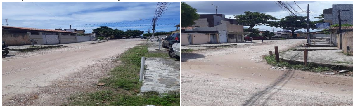
Figura 28 – Rua Álvaro Henrique Correia com apenas um pequeno trecho calçado, estando sua maior extensão sem a conclusão do calçamento no bairro do Valentina
