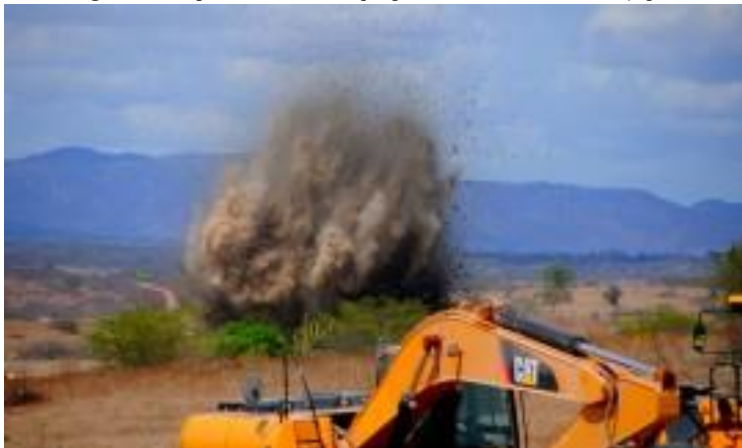
Figura 3 – Explosão do terreno que passará o canal Acauã-Araçagi
