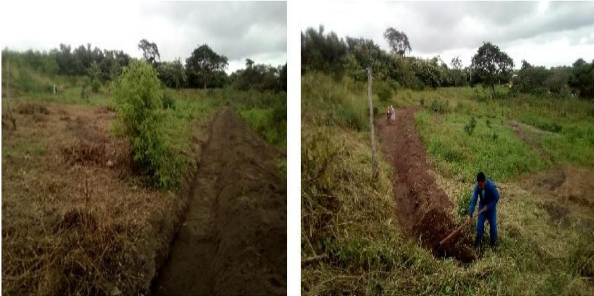
Figura 7 - Abertura das valas de infiltração e levantamento dos barramentos.
