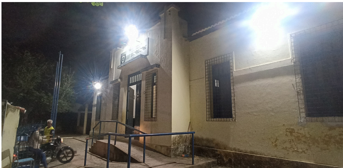
Figura 03. Rampa de acesso ao prédio da EEEF Dom Santino Coutinho, Pilões/PB.
