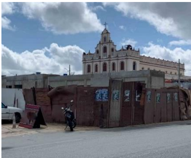
Figura 9 - Construção da nova Rodoviária
