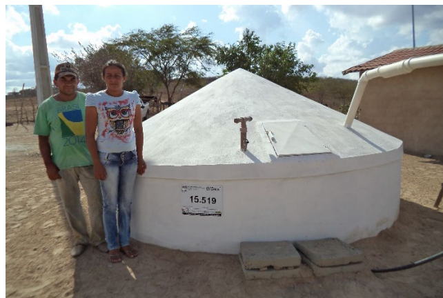
Figura 3 - Construção de cisternas de placas, Programa Um Milhão de Cisternas. Trabalho realizado pela Comissão de Recursos Hídricos.
