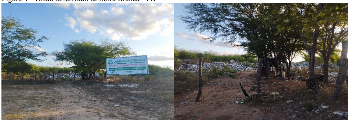
Figura 4 – Lixão desativado de Serra Branca - PB
