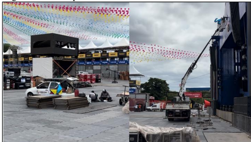
Figura 9 – Montagem da área Vip no Terreiro do Forró
