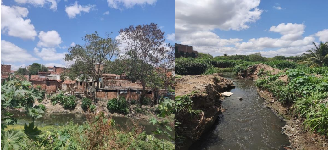
Figura 9 - Moradias de risco bairro Catingueira
