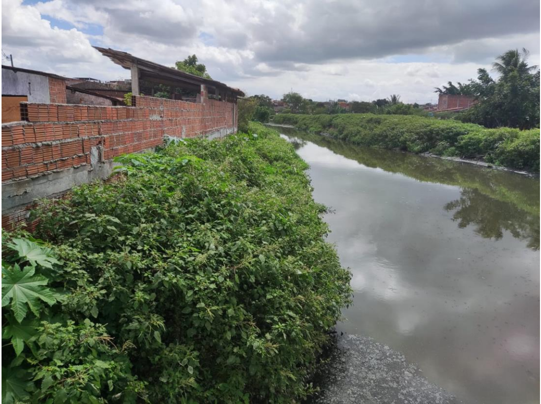
Figura 15 - Construções a margem do rio
