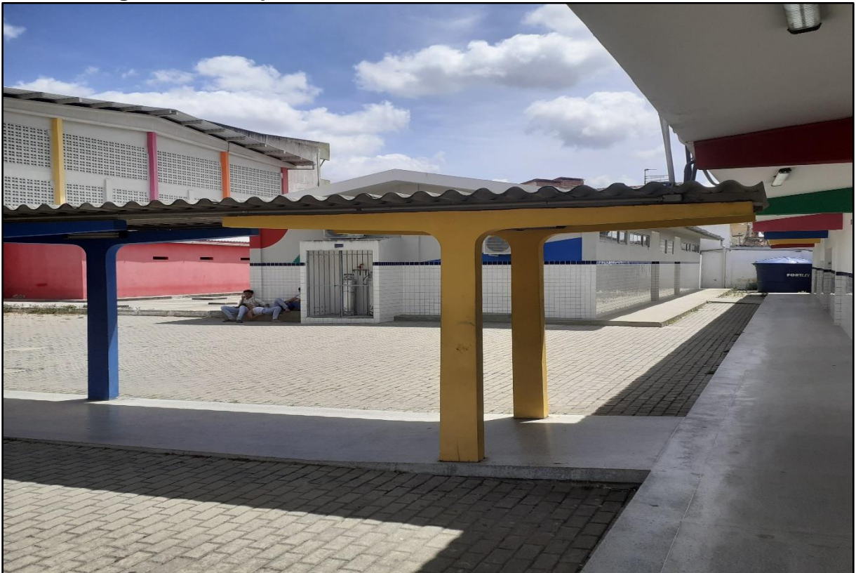
Figura 5 - Fotografia parcial dos corredores das salas de aula, uma parte do novo ginásio de esportes e ao centro o local dos novos laboratórios.
