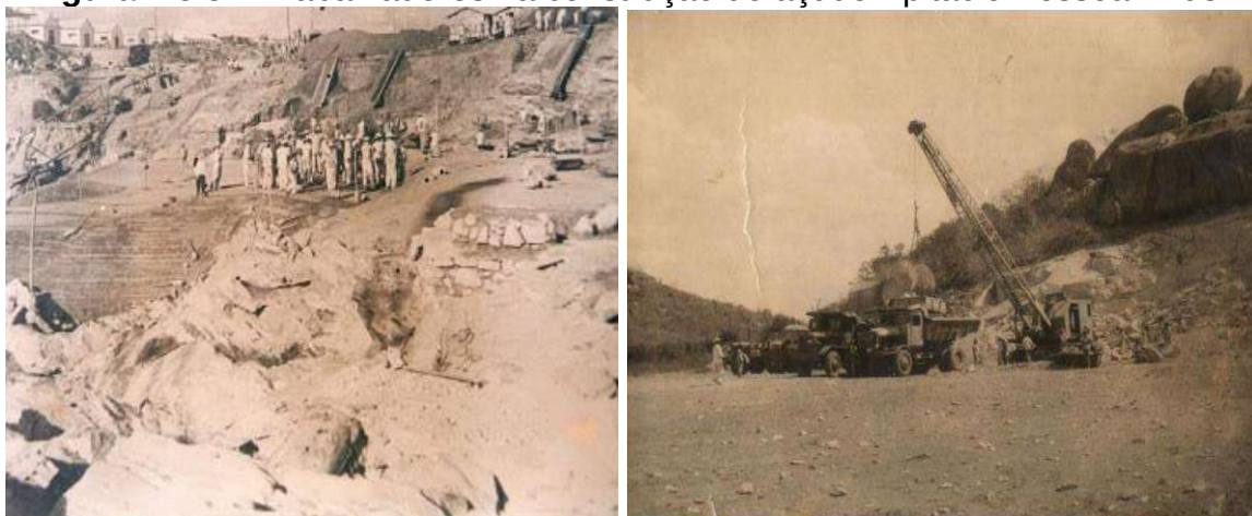
Figura 4 e 5 – Trabalhadores na construção do açude Epitácio Pessoa - 1951
